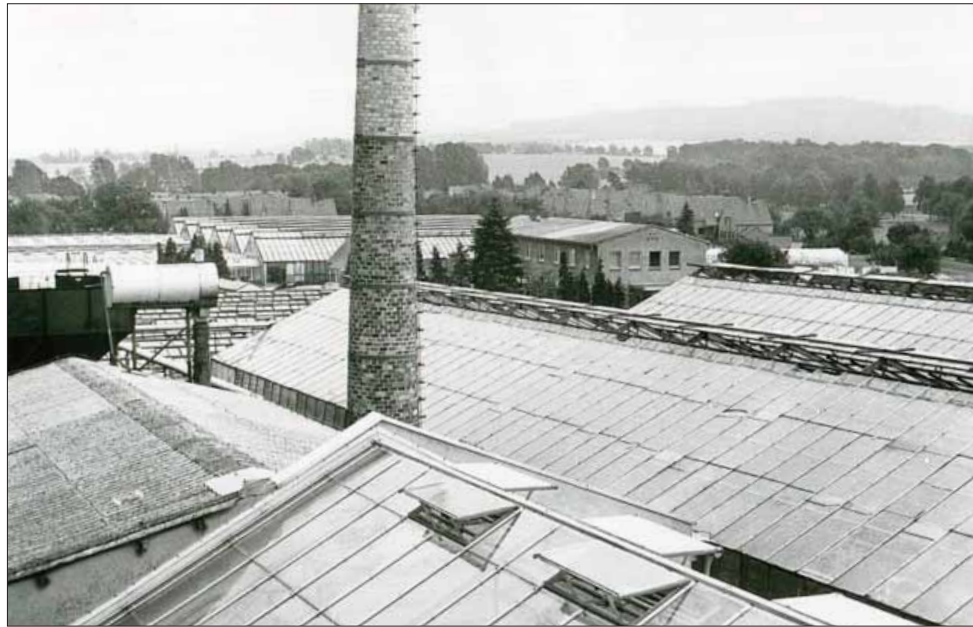
Gewaltiger Gewächshauskomplex: Ansicht auf das Gelände aus westlicher Richtung.
